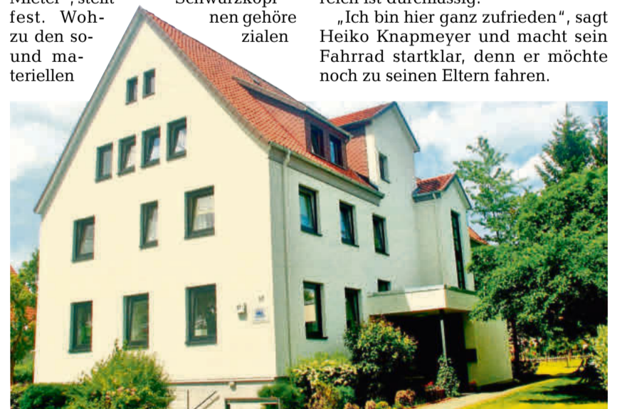
Auch im Haus an der Schieblerstraße gibt es ein Wohnangebot.
